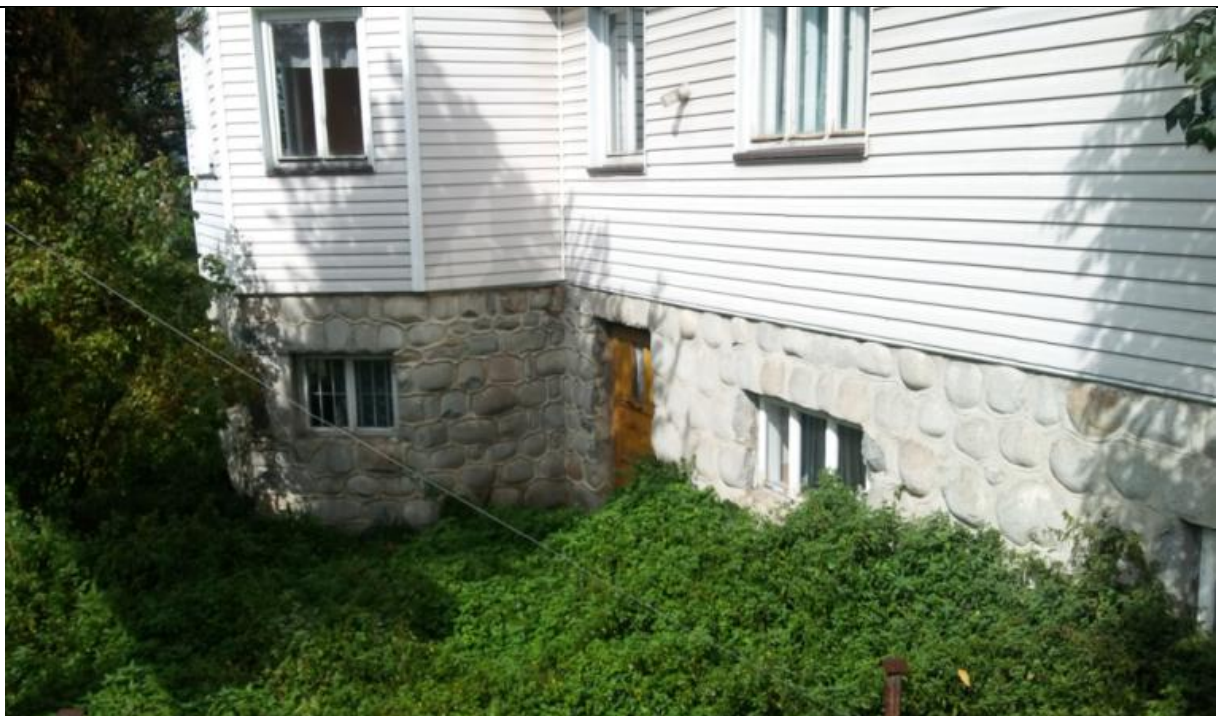
WIDOK NA OKŁADZINĘ KAMIENNĄ NA ELEWACJI POŁUDNIOWO-ZACHODNIEJ
